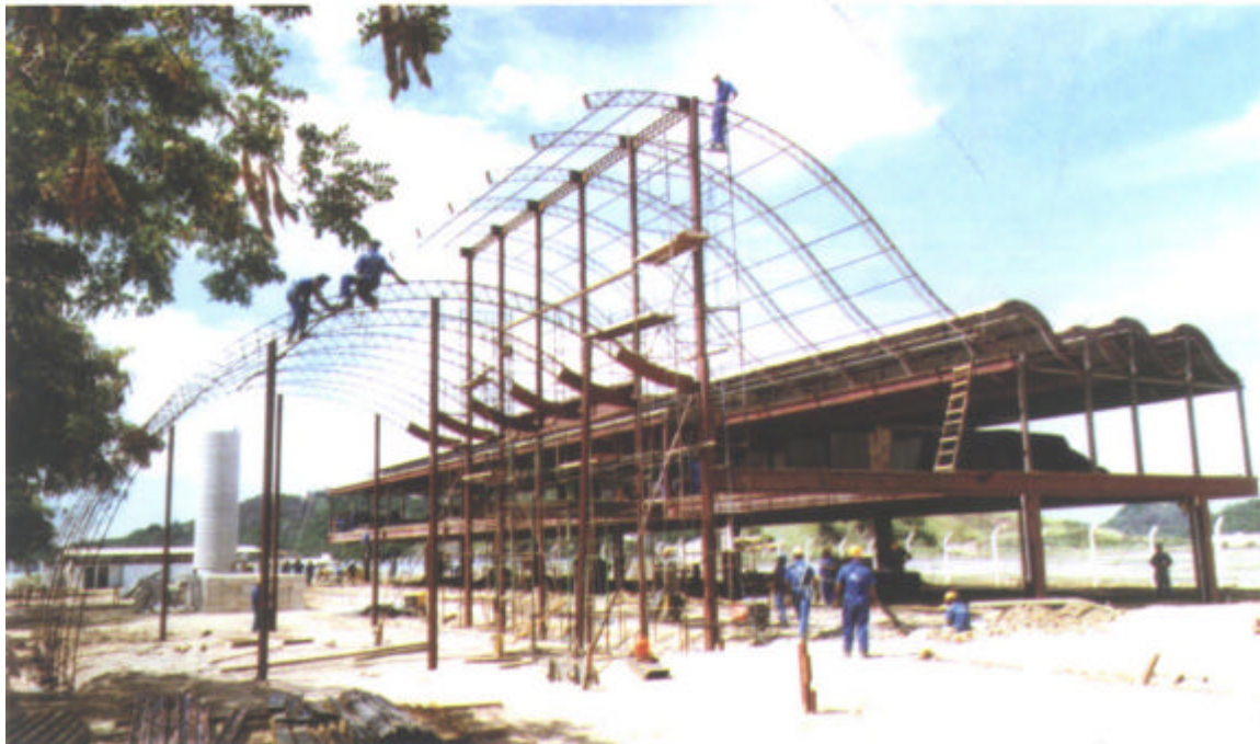
Figura 4.23 – Sede do Tribunal de Contas da União no Estado do Espírito Santo – CTRS – Vitória, ES, Brasil, 1998. Arquiteto: João Filgueiras Lima, Lelé. Croqui – corte transversal do edifício. Vista geral da construção, com as estruturas metálicas do auditório em primeiro plano, na fase de montagem.
