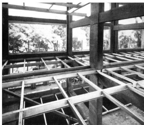
Figura 3.7 – Unidade Habitacional de Tamanho Adequado, Marselha, França, 1946-51. Arquiteto: Le Corbusier. Construção, macro estrutura em concreto e infra estrutura em aço. Unidades independentes da estrutura.
