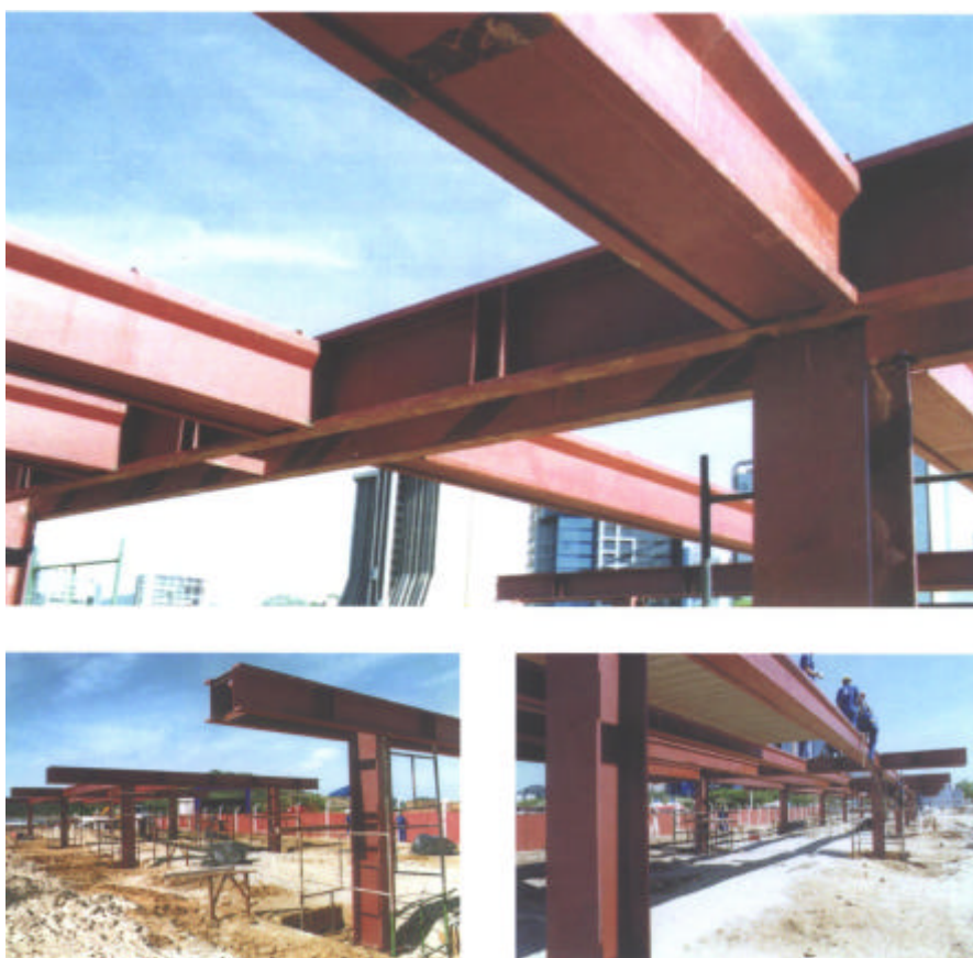
Figura 4.27 – Sede do Tribunal de Contas da União no Estado do Espírito Santo – CTRS – Vitória, ES, Brasil, 1998. Arquiteto: João Filgueiras Lima, Lelé. Vigas de piso mistas (aço-concreto). Vistas dos pórticos principais montados. Colocação das lajes pré-fabricadas sobre as vigas de piso.
