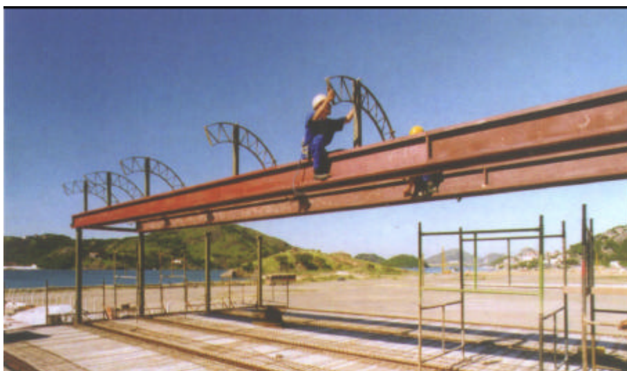
Figura 4.31 – Sede do Tribunal de Contas da União no Estado do Espírito Santo – CTRS – Vitória, ES, Brasil, 1998. Arquiteto: João Filgueiras Lima, Lelé. Treliza de cobertura dos sheds. Início da montagem das treliças de cobertura em forma de sheds.
