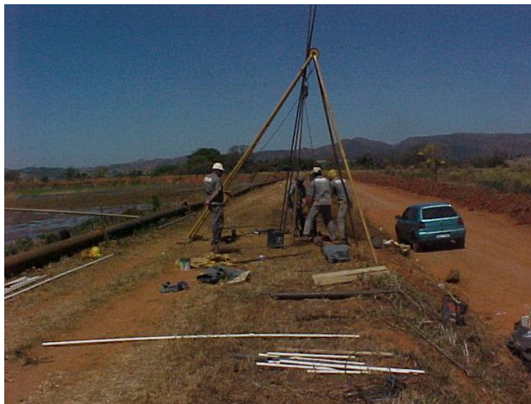
Figura 4.3 – Execução de sondagem SPT ao longo de berma da barragem de rejeitos
