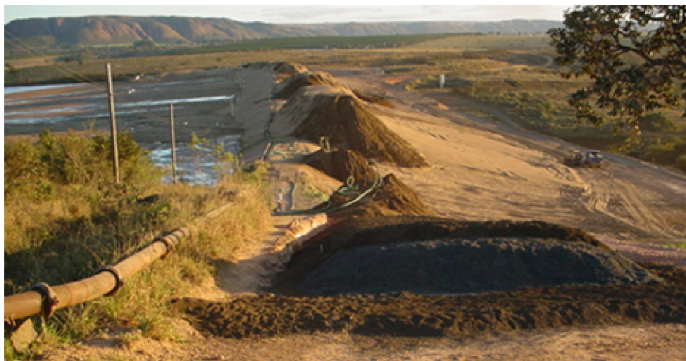
Figura 3.12 – Material acumulado para execução de novo alteamento e detalhe do sistema de drenagem das ombreiras.
