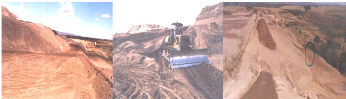
Figura 4.6 – Fases do processo de compactação da barragem B5
