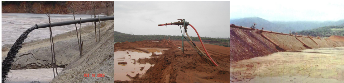
Figura 2.5 – Descarga em ponto único, Ciclonagem e Espigotamento de rejeitos.
