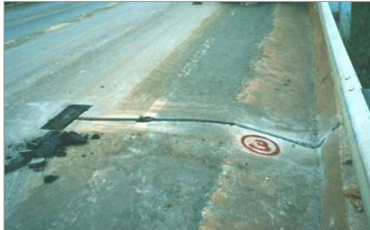
Figura 3.21 – Marcação das seções (seção 03) para controle da instalação dos corpos de prova
