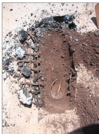
Figura 4. 51 – Limpeza e retirada da geogrelha
