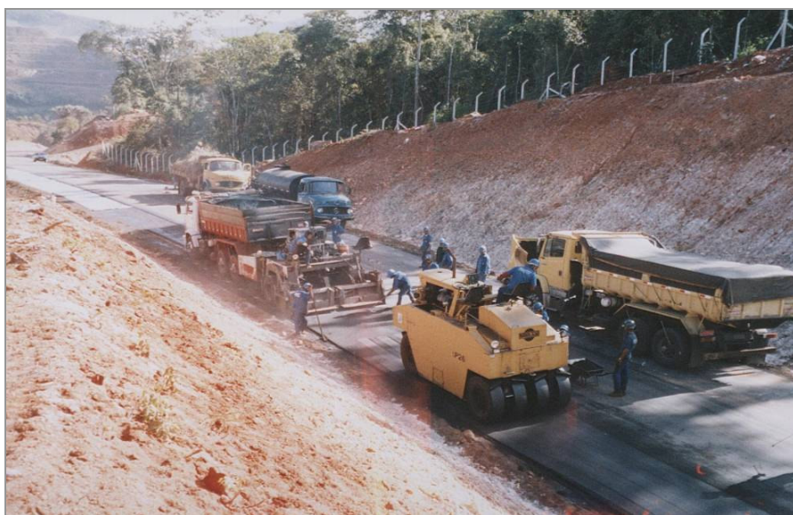
Figura 3. 9 – Execução do revestimento asfáltico com CBUQ
