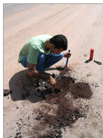
Figura 4. 52 – Escavação da base para descoberta do sensor
