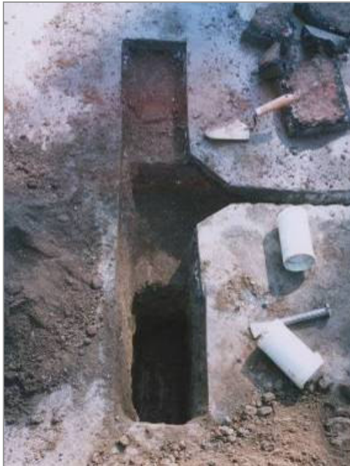
Figura 3.23 – Escavação da seção 01 mostrando a base, sub-base e o subleito
