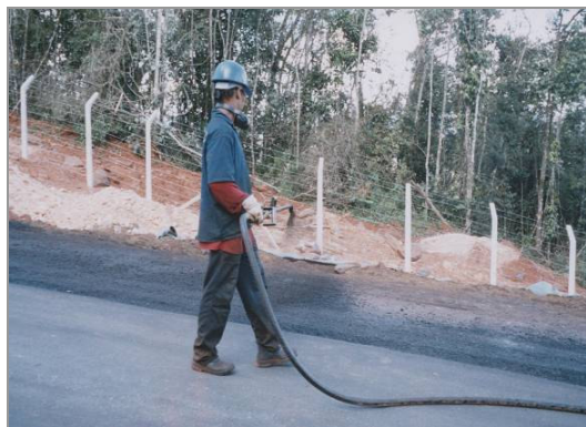
Figura 3. 7 – Aplicação de banho de ligação no geotêxtil
