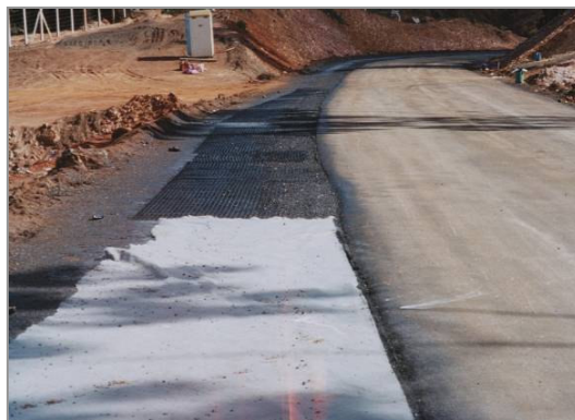
Figura 3. 8 – Aplicação de geotêxtil na seção 03 e geogrelha na seção 04
