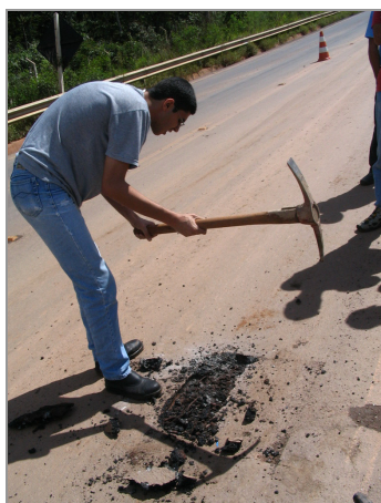
Figura 4. 50 – Corte manual do asfalto com picareta
