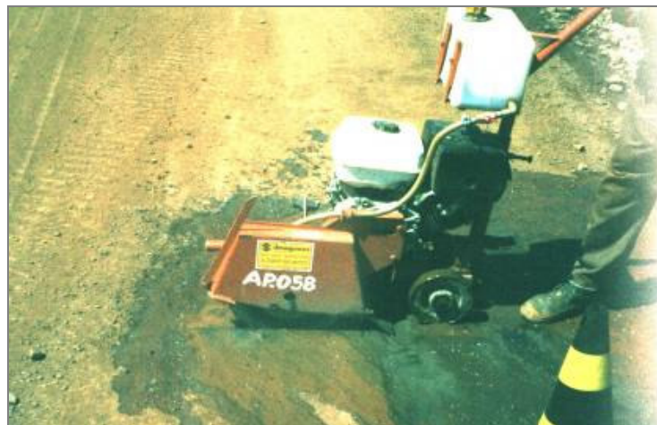
Figura 3.22 – Serra circular cortando o asfalto para a colocação dos sensores
