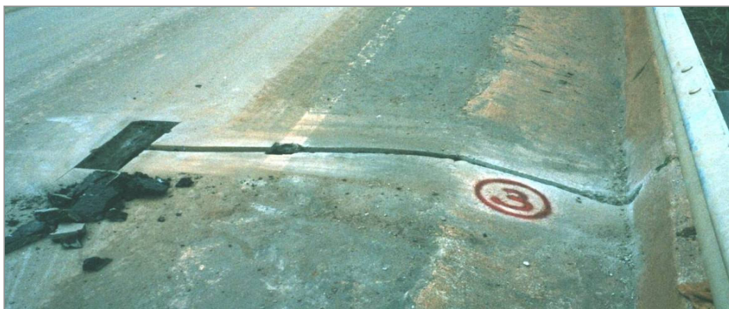
Figura 5. 2 – Corte no asfalto e sarjeta para passagem da tubulação
