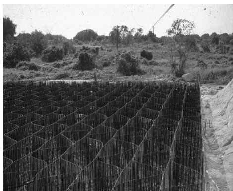
Figura 2.12 – Extrusão lateral devido ao recalque do aterro
