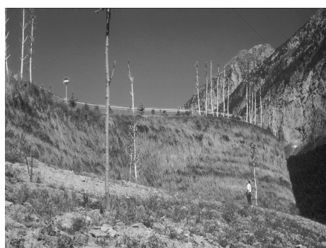
Figura 2.16 – Muro reforçado com face em cobertura vegetal
