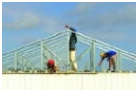
Figura 3.17 – Montagem estrutura da cobertura.
