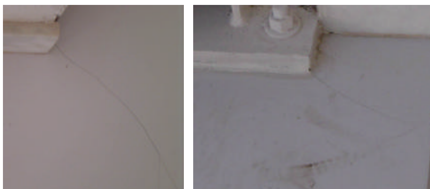
Figura 4.45 –Cerâmicas de piso trincadas. FONTE: Arquivo pessoal.
