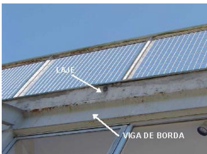
Figura 4.27 – Detalhe comprometimento da viga de borda da laje do terraço. FONTE: Arquivo pessoal
