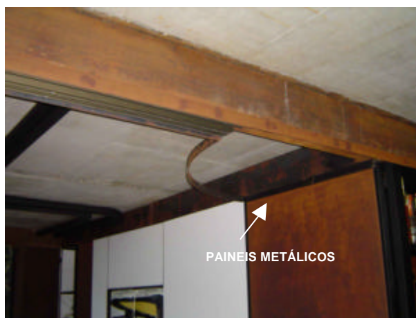
(b) Painéis metálicos pivotantes/deslizantes para fechamento da cozinha
