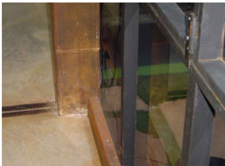
Figura A.17– Detalhe estrutura da pele de vidro em metalon.
