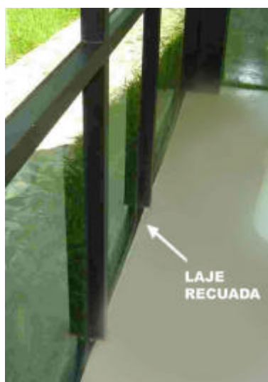
Figura 4.58– Detalhe da pele de vidro e do recuo da laje. FONTE: Arquivo pessoal.
