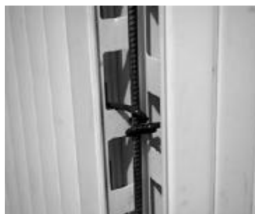
Figura 3.16 – Estrutura de ancoragem entre paredes.
