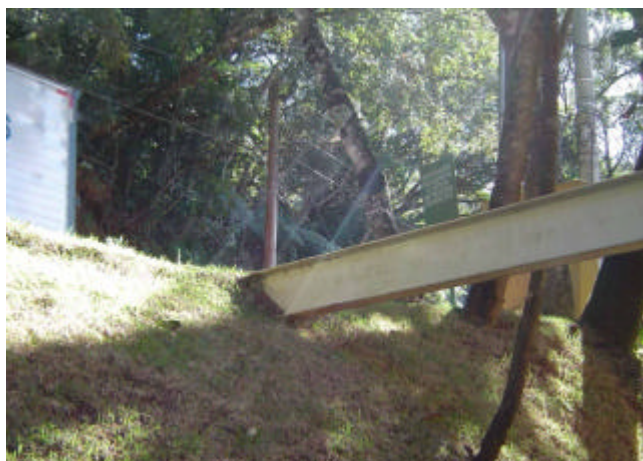
Figura 4.13 – Viga de ancoragem descarregando diretamente na fundação.
