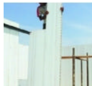
(c) Montagem e encaixe dos perfis de PVC
