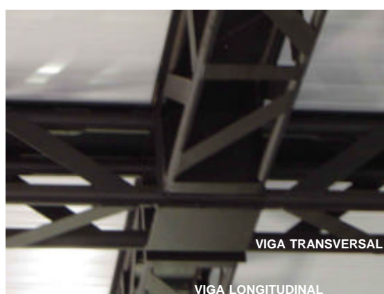
Figura A.4– Diferenças de bitolas dos tubos das vigas transversal e longitudinal.
