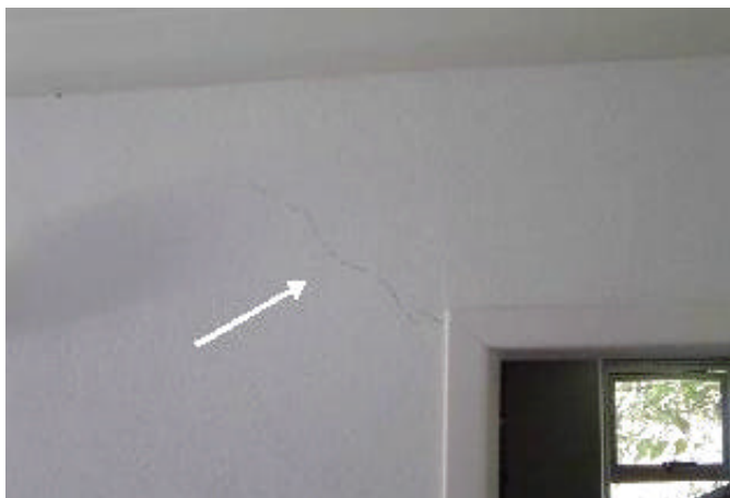
Figura 4.18 – Trinca possivelmente relacionada à falta de junta de expansão entre a viga metálica e a alvenaria.
