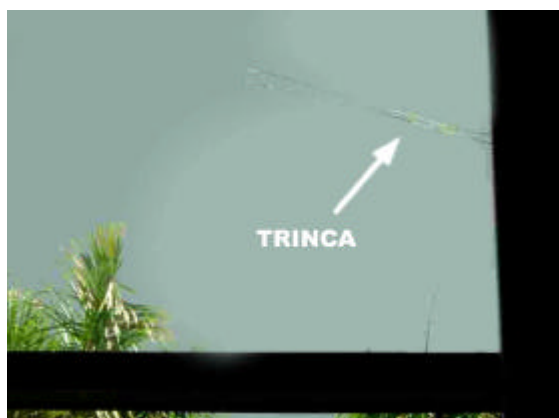
Figura 4.62 – Chapa de vidro trincada.
