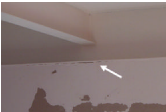
Figura 4.42 – Fissura entre viga e alvenaria, e recomposição de pintura. FONTE: Arquivo pessoal.
