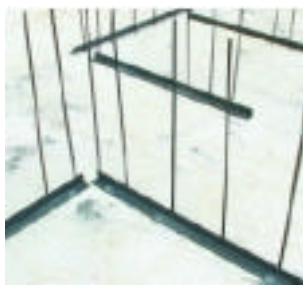
(b) Ancoragem dos painéis com o piso
