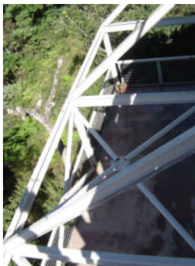
Figura 4.17 – Contraventamento horizontal acrescido. FONTE: Arquivo do construtor
