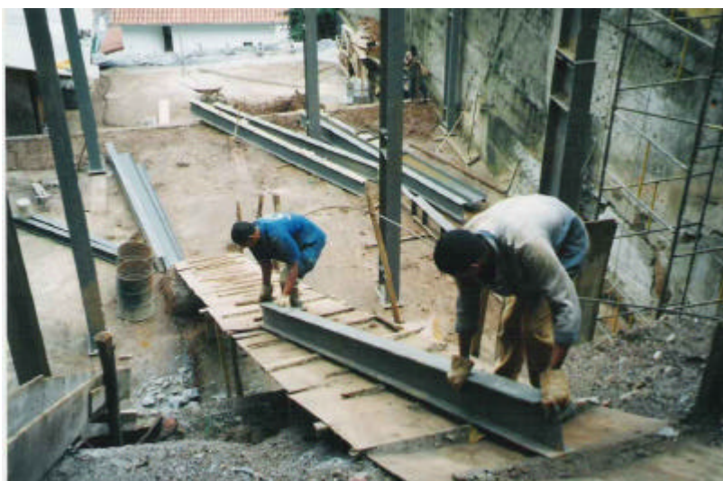
Figura 4.41 – Desembarque manual da estrutura pela rampa de acesso. FONTE: Arquivo do arquiteto.
