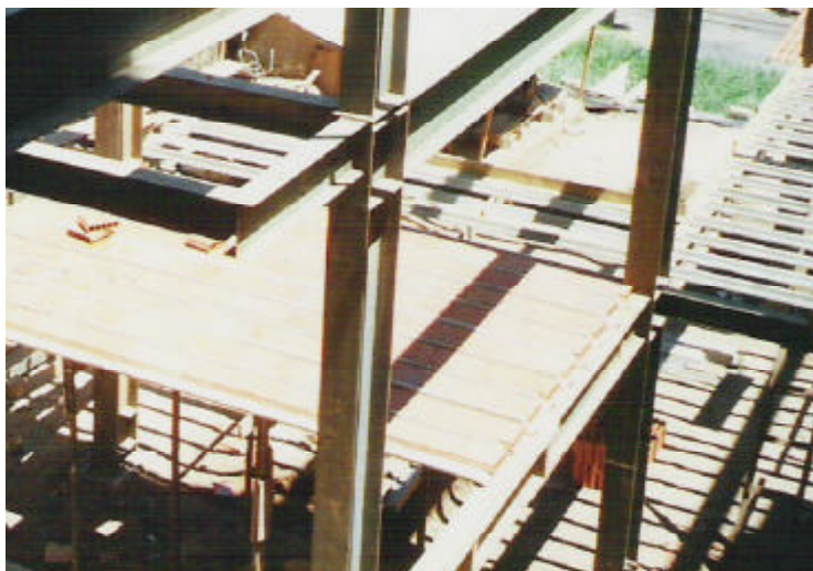
Figura 4.33 – Montagem das lajes pré-fabricadas.
