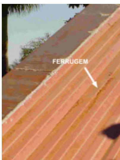
Figura 4.63 – Limalha corroída aderida à superfície da telha metálica.
