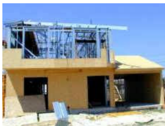
(b) Fechamento de residência em OSB
