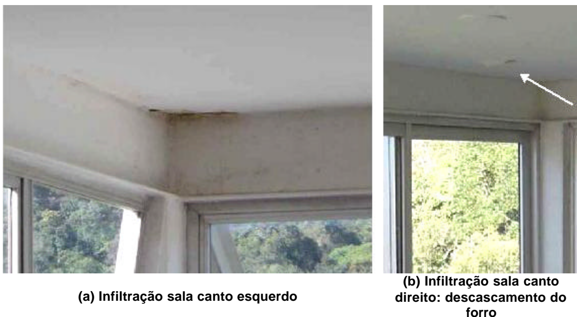
Figura 4.25 – Pontos de infiltração na sala de convívio.
