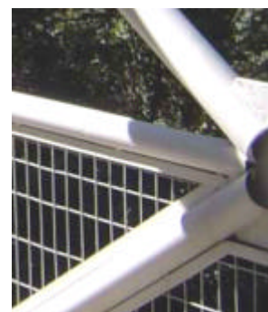
(c) Det. nó contraventamento vertical
