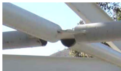
(b) Det. nó contraventamento horizontal
