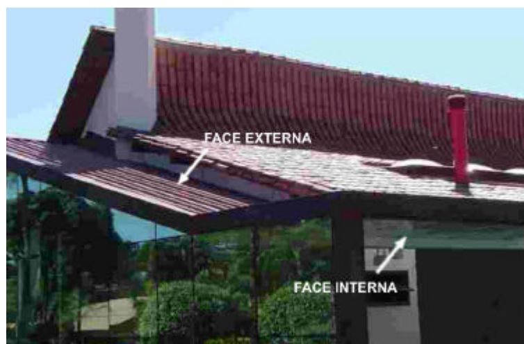
Figura 4.53– Vista telha sanduíche. FONTE: Arquivo pessoal.
