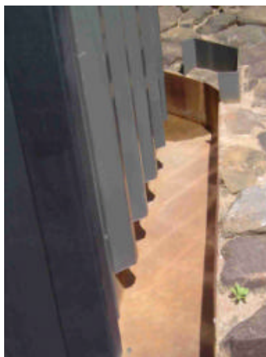
Figura A.7– Detalhe da calha de captação da água que percola pelo fechamento vertical.
