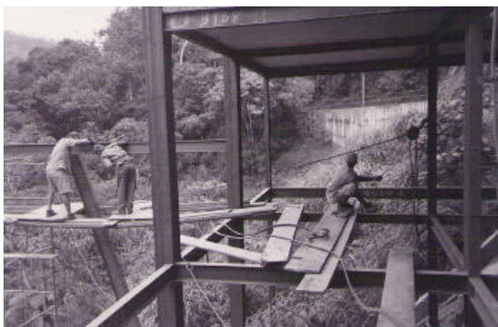
Figura 4.16 – Posicionamento do pilar inclinado com utilização de tifo. FONTE: Arquivo do construtor
